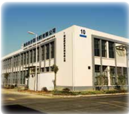
Nabell China (Dan Yang) Corporation [JAPIC工業団地内 第10棟] 敷地面積 1,500㎡ 延床面積 1,492.88㎡
