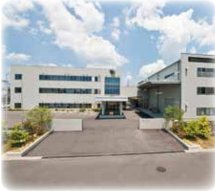
本社・三重工場 敷地面積 8,504㎡ 建物面積 3,384㎡ 延床面積 6,868㎡
