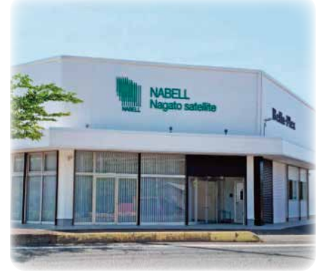
長門サテライト工場 敷地面積 1,060㎡ 延床面積 295㎡
